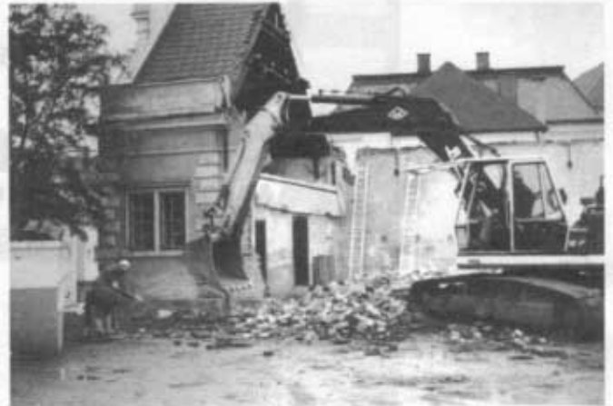
Abbrucharbeiten an der alten Turnhalle
