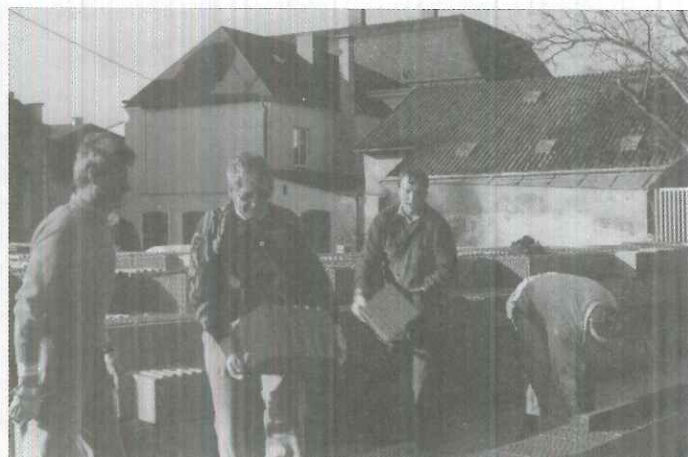
Kräftig zugepackt wurde immer auf der Baustelle
